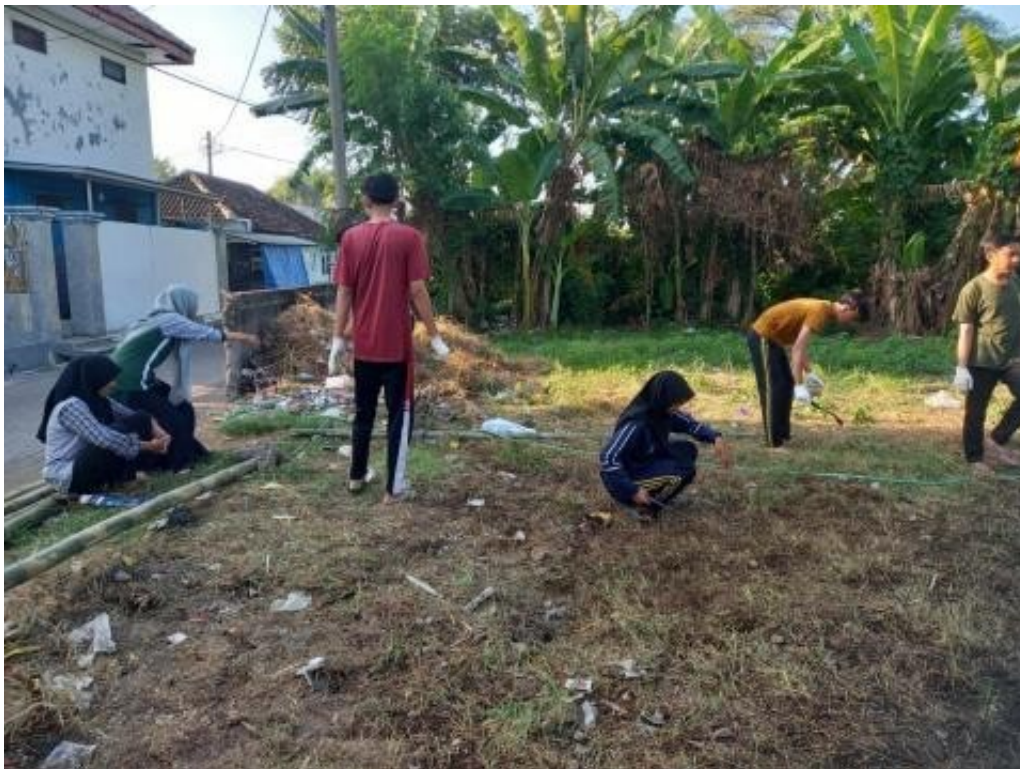
Figure 5. Proses Pembangunan Greenhouse
