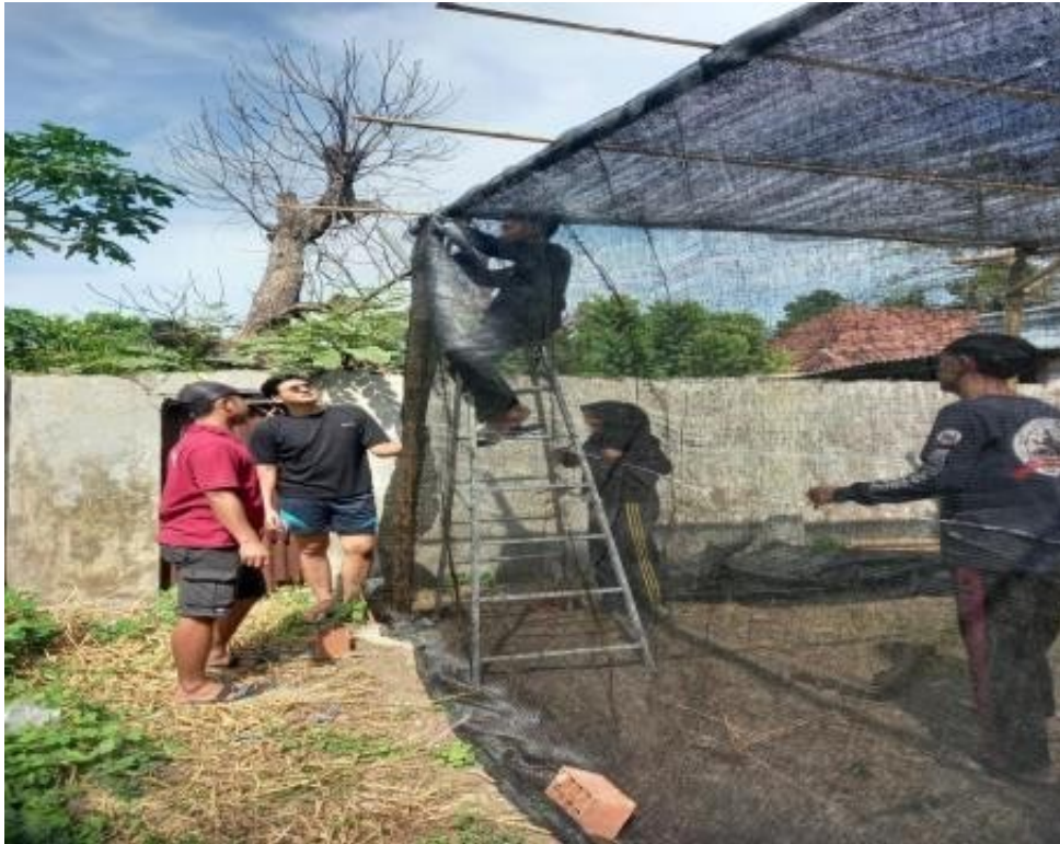
Figure 4. Proses Pembangunan Greenhouse
