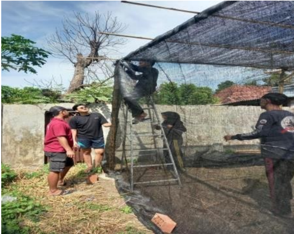
Figure 4. Proses Pembangunan Greenhouse
