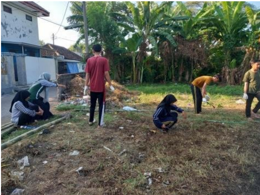
Figure 5. Proses Pembangunan Greenhouse
