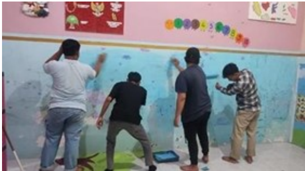
Figure 1. Kondisi Awal Dinding TK ABA VII Kalipecabean
