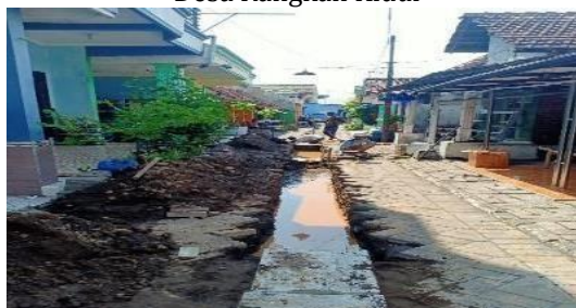
Gambar 1. Pembangunan Gorong-gorong di Desa Rangkah Kidul
